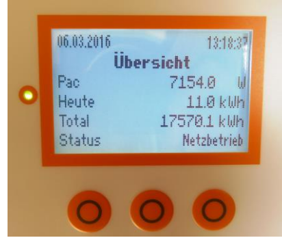
Wechselrichter 2
