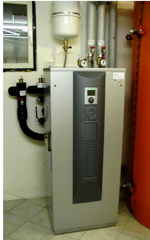
Bild 3+4: Alte Anlage (1985) mit WP, Pufferspeicher und externem Plattenwärmetauscher 1996) zur Direkten Kühlung sowie kompakte neue Anlage (2008)
